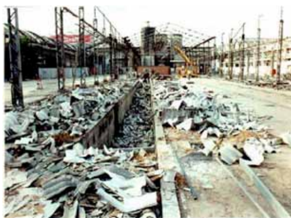
Descomissionamento da fábrica de cimento de amianto em Osasco, São Paulo. Foto: Eduardo Metroviche - Sindicato dos Metalúrgicos de Osasco e Região.
