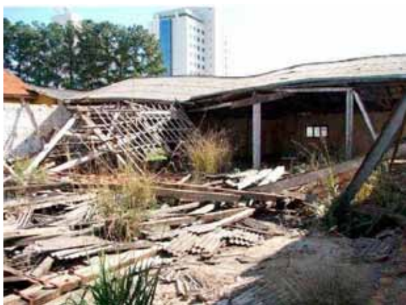
Descomissionamento da fábrica da Divisão Wagner Wall em Ponta Grossa, Paraná. Foto: Fernanda Giannasi.
